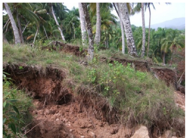
Figura 7c. Afectación a plantación de coco y presencia de material arcilloso arenoso de color pardo rojizo.
