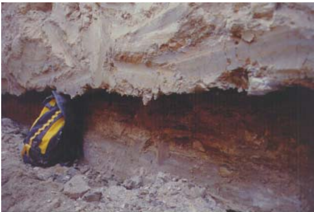
Figura 9. Deslizamiento de un plano en el sondeo 7, el movimiento observado fue de 20 cm y se registro a las 24 horas después de excavado el pozo. El bloque de arriba corresponde a un paquete de areniscas mientras que el paquete de abajo es de lutitas y areniscas.
