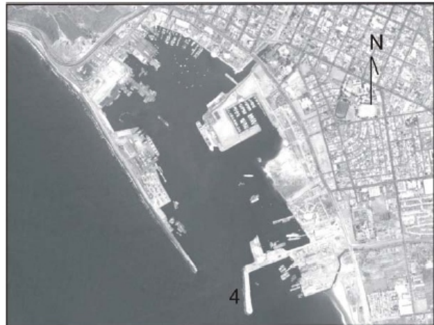
Figura 4. Fotografía del puerto de Ensenada, Baja California, que muestra la cuarta escollera (4) en el extremo sur del puerto, construida en el año 2006, cuya longitud es de 320 m de longitud. Imagen DigitalGlobe, enero, 2008.
