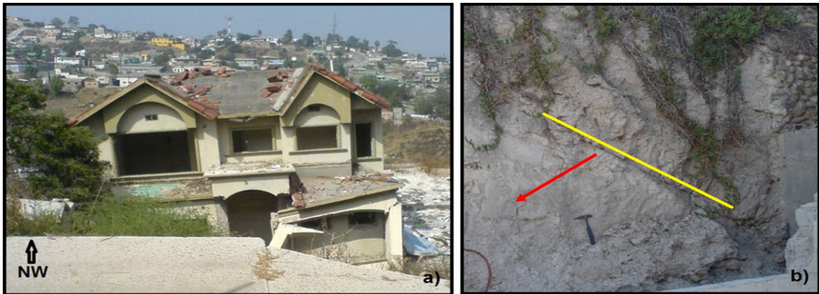
Fig.6. a) Zona de colapso de una casa por reactivación de una falla normal con movimiento hacia el W, localizada hacia el NE del fraccionamiento Acantilado; la corona del deslizamiento es mayor a los 50 m. b) Falla normal con movimiento lateral derecho, indicando con la flecha el movimiento del bloque donde se encuentra el observador. Se infiere la existencia de una familia de fallas conjugadas desarrolladas en material compuesto por arenas pobremente consolidadas.
