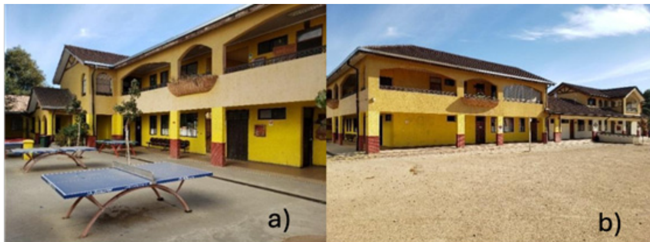
Figura 2. Fotografías del exterior del LTP-ES. a) Vista sur del LTP-ES, sector salas de clases b) Vista este del LTP-ES, sector salas de clases.
