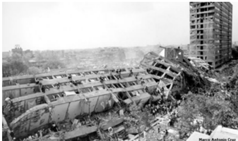
Figura 11. Fotografía del edificio Nuevo León de Tlatelolco, en que murieron entre 200 y 300 personas en el sismo de 1985. Imagen tomada de Najjar (2017).
