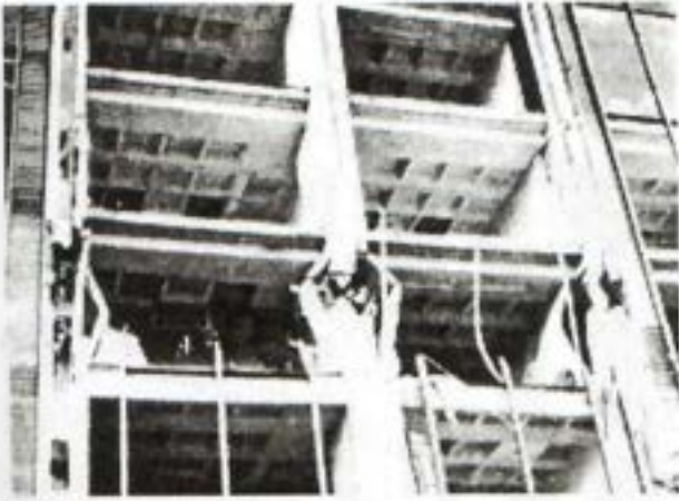
Figura 2. Columnas débiles
