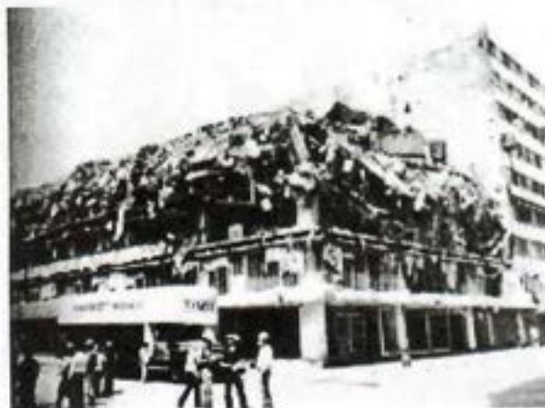
Figura 6. Colapso de los pisos superiores
