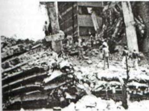
Figura 3. Construcción con lozas planas
