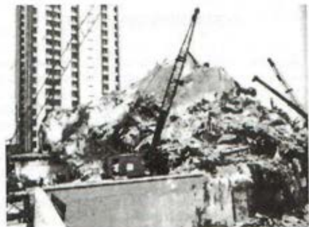
Figura 5. Torres colapsadas en Pino Suárez
