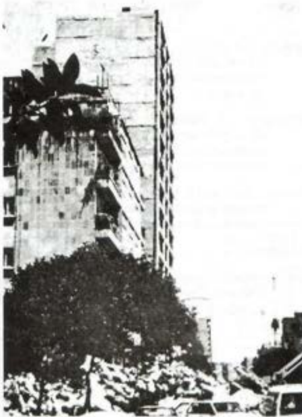
Figura 8. Falla de cimentación
