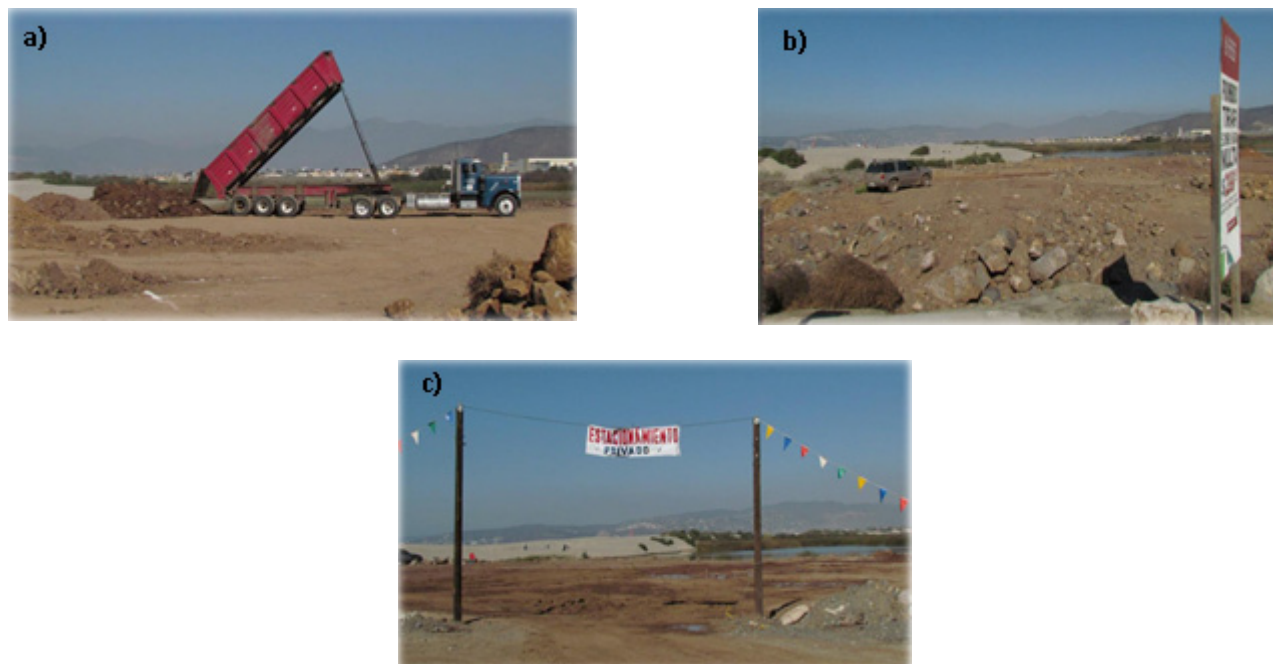
Figura 5. Modificación del terreno de La Lagunita; a) Camión de volteo arrojando materiales en el área de La Lagunita (2012); b) Zona de La Lagunita con material ajeno al del área (2012); c). Área habilitada para estacionamiento en el área de La Lagunita (2012).
