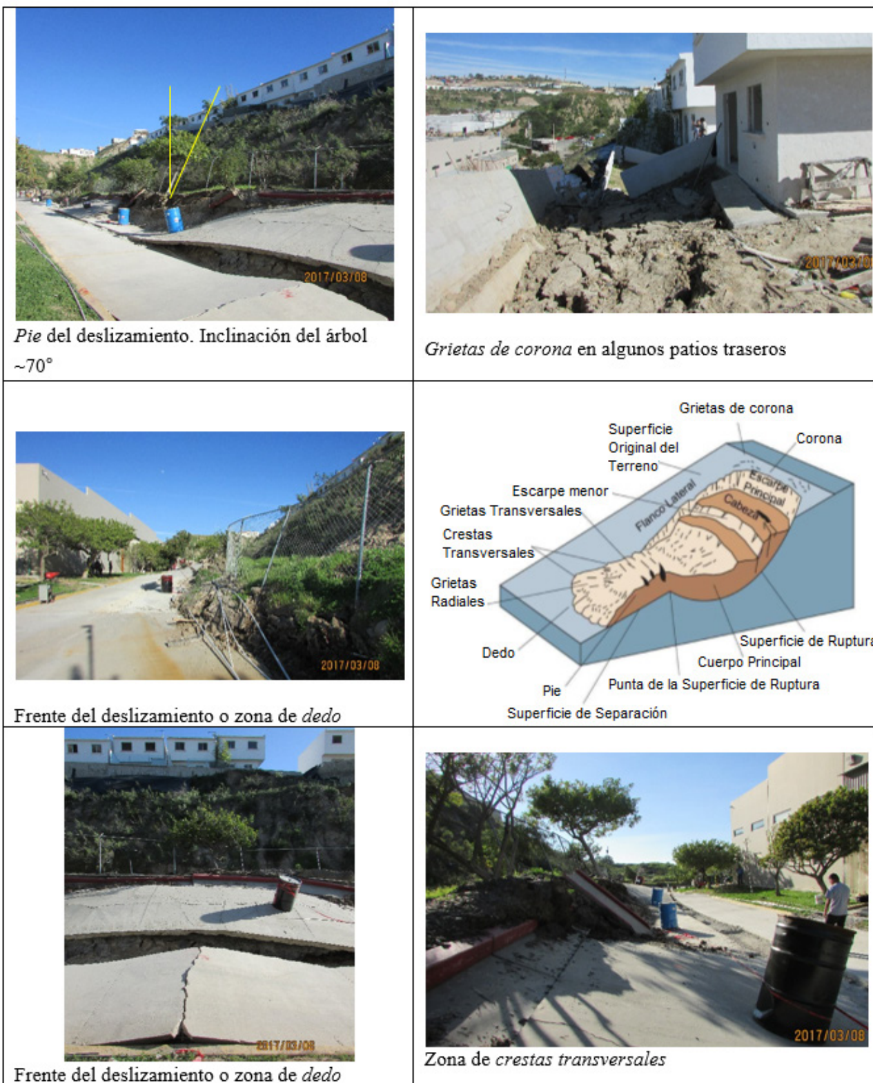
Figura 9. Identificación de las diferentes partes del deslizamiento rotacional entre el fraccionamiento Valle del Sur y la planta BBS de acuerdo con el modelo de Highland y Bobrowsky (2008). Los nombres en italicas se refieren a los nombres del modelo de deslizamiento.
