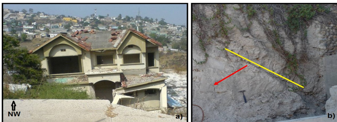
Fig.6. a) Zona de colapso de una casa por reactivación de una falla normal con movimiento hacia el W, localizada hacia el NE del fraccionamiento Acantilado; la corona del deslizamiento es mayor a los 50 m. b) Falla normal con movimiento lateral derecho, indicando con la flecha el movimiento del bloque donde se encuentra el observador. Se infiere la existencia de una familia de fallas conjugadas desarrolladas en material compuesto por arenas pobremente consolidadas.
