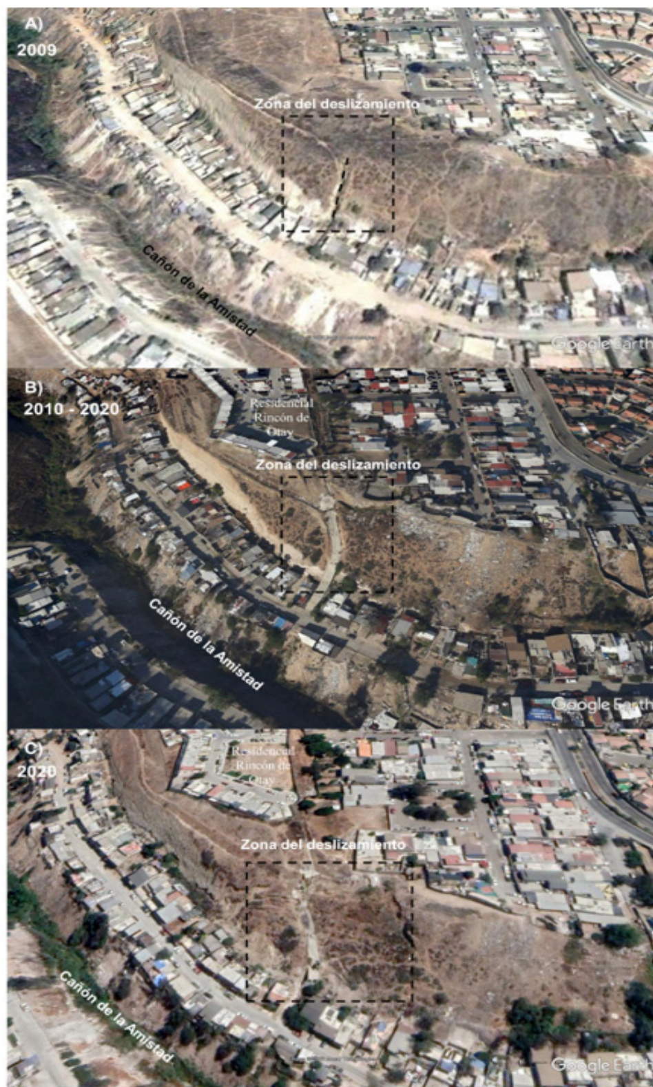
Figura 5. Evolución de la zona del deslizamiento (cuadro de línea segmentada). A) Hasta 2009, la zona del deslizamiento era una depresión con orientación NNE-SSW (línea negra segmentada). B) Del 2010 al 2020, se observa la depresión rellena. C) En el 2020, ocurre el deslizamiento dañando la obra construida sobre la depresión (imágenes tomadas de Google Earth).
