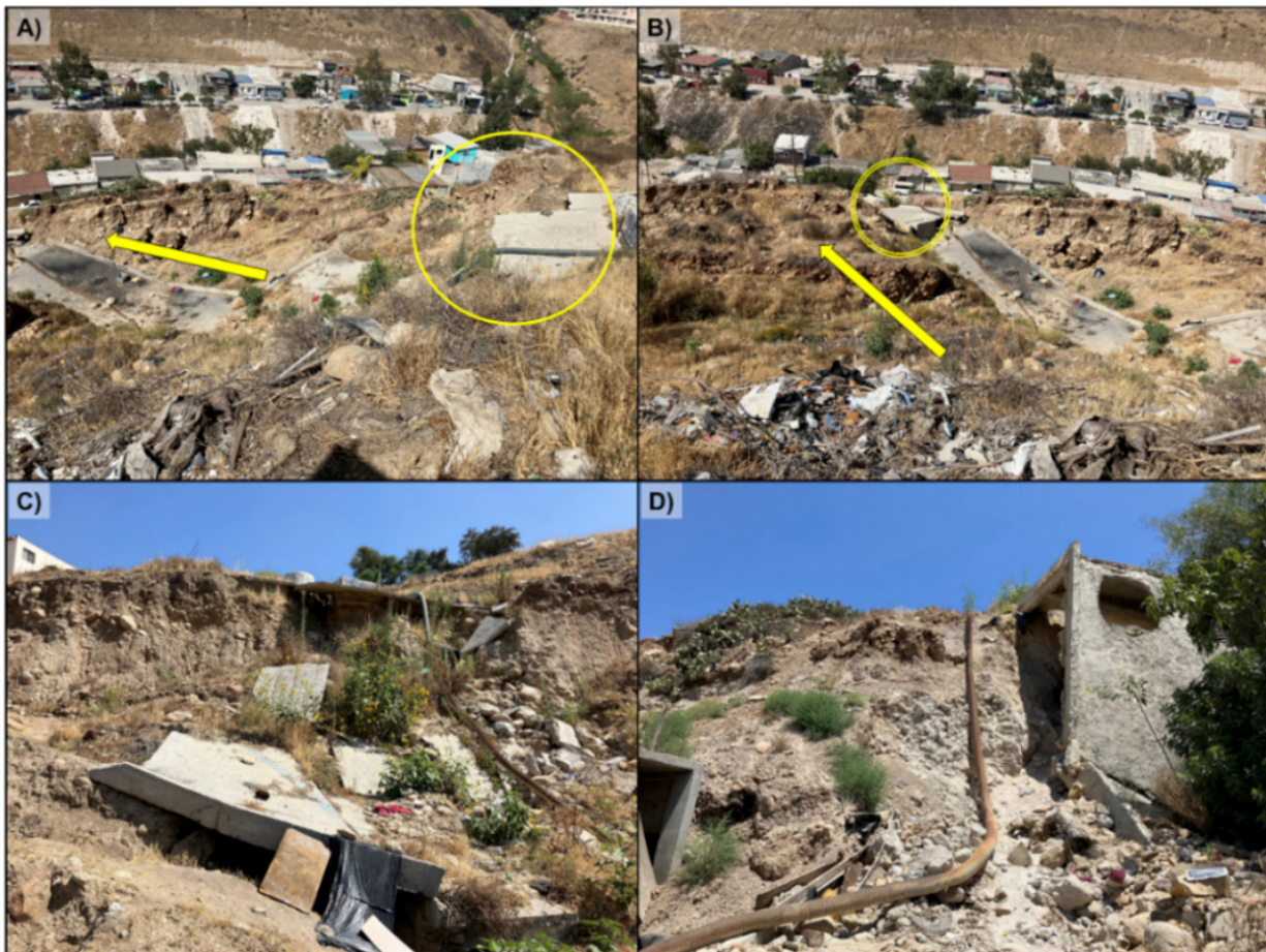
Figura 3. A) y B) Deslizamiento ocurrido en la colonia Vista Alamar. Las flechas amarillas indican la dirección y sentido del movimiento, el círculo amarillo es el acercamiento visto en C, el círculo amarillo con doble línea es el acercamiento en D.
