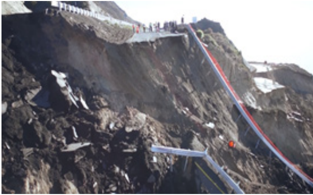
Figura 13. La imagen muestra el derrumbe de la carretera que conecta a las ciudades de Tijuana y Mexicali, B.C., causado por el sismo del 2010.
