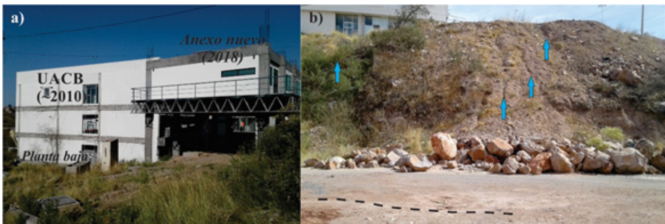
Figura 11. a) Imagen del edificio de la Unidad Académica de Ciencias Biológicas (UACB) viendo hacia el oeste y el nuevo anexo. Los perfiles de georadar hechos con la antena de 500 MHz fueron en la planta baja del edificio que empezó a utilizarse en 2010. b) En la parte sur del edificio de la UACB se observa el material de relleno y la formación de cárcavas (flechas azules); la línea negra discontinua muestra una fractura perpendicular a la pendiente. De la cabecera de la cárcava de la parte izquierda de la figura hacia el edificio hay una distancia aproximada de 4 m.
