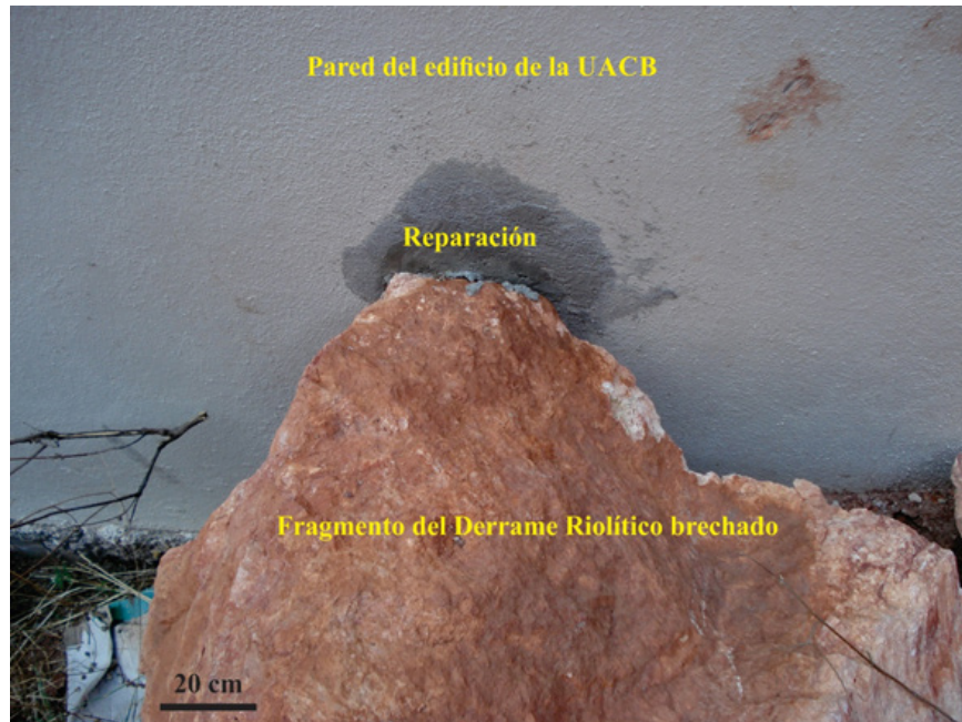
Figura 2. Fragmento de un derrame riolítico que en junio de 2016 rompió la pared del Laboratorio de Docencia de Química y Bioquímica de la UACB de la UAZ.
