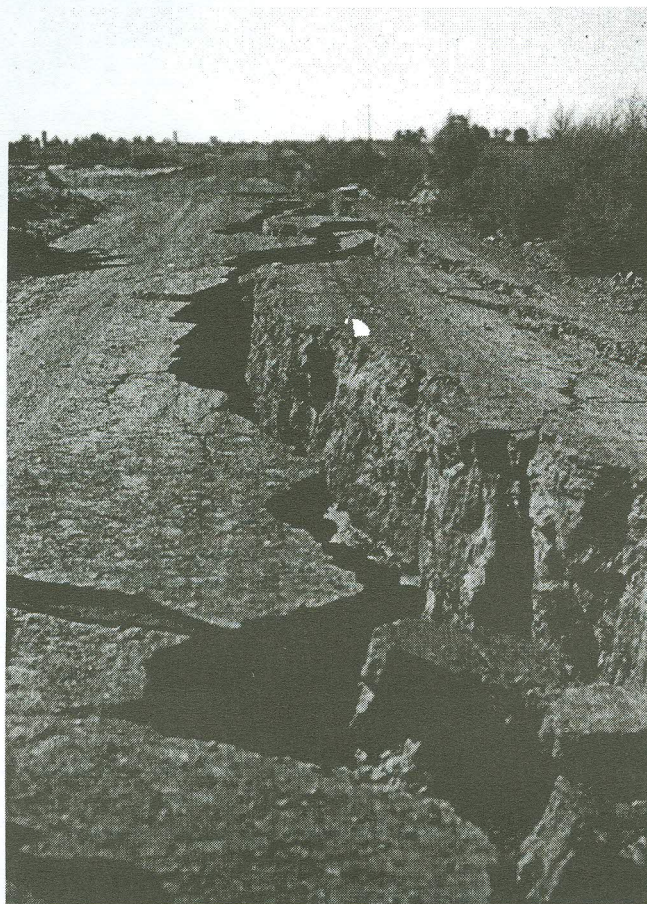
Figura 10. Fracturas generales por el temblor de Victoria del 8 junio de 1980 en la zona de pozos de extracción de vapor, en el campo geotérmico de Cerro Prieto.
