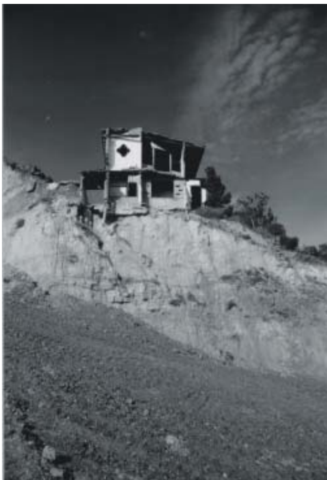
Figura 3. Casa afectada por la cabecera del deslizamiento de 1976. Esta foto se tomó en febrero de 1996 y la casa y la pared tienen el mismo aspecto que tuvieron inmediatamente después del deslizamiento.
