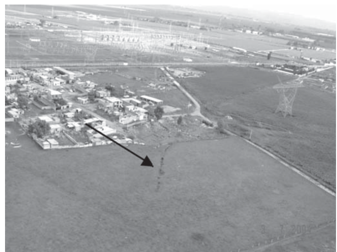
Figura 4. Ubicación de la grieta de 2004 que se formó cerca de la localidad Potrero de la Soledad, aledaño a la localidad de Nextipac. La flecha indica la ubicación de la grieta.
